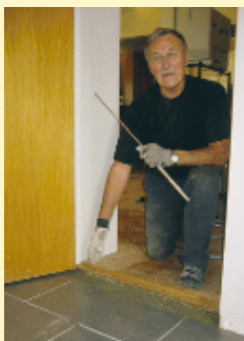
Fliselegger Roy legger siste flis på kjøkkenet.
